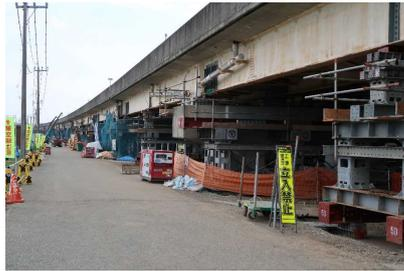
地震の被害例はたくさんありますが、2016年の熊本地震の例を紹介します。ネットで調べると様々な情報が得られますが、一つ目のなかぐろのようないわゆる地震学的なメカニズムの説明があります。これは設計レベルを決めるために重要です。が、我々の仕事は二つ目の中黒の被害とその普及です。熊本城の城壁崩壊は有名ですし、中の道路のずれのような目視で詳細がわかる場所は対応しやすいものです。熊本地震だけではなく、発震時に崩壊する構造も時間をおいて徐々に崩壊する構造もあり、二回続けて振動7の地震動は致命的です。右の写真は益城町付近の九州自動車道の対策工事ですが、緊急車両を通しながら、軟弱地盤(周りは水田)で地上からは普通見えない見えない地下の基礎対策は掘削調査後の大工事です。
