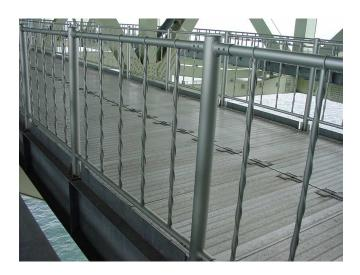
タイで結合し振動数を高める →破損する例もある
